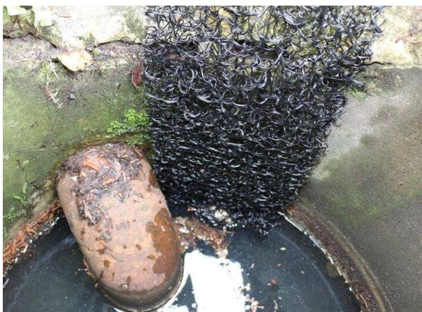
Falls Tauchbogen vorhanden, die Ausstiegshilfe so am Schachtdeckel befestigen, dass die Ausstiegshilfe neben dem Tauchbogen ins Wasser hängt.
