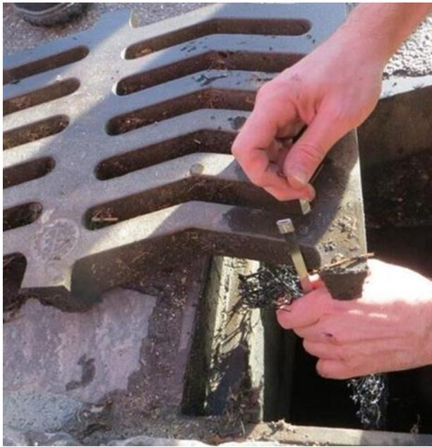
Matte mit Metallkabelbinder an Deckel befestigen.
